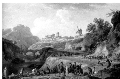
ill.3- Claude-Joseph Vernet La construction d'un grand chemin Paris, Musée du Louvre RMN / © Photo Franck Roux
