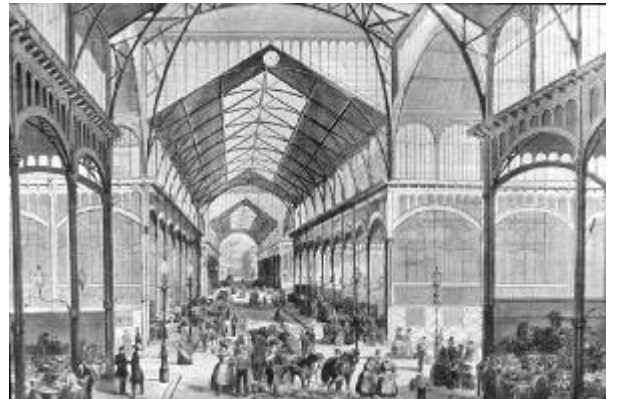
Détail des Halles avec ses structures
